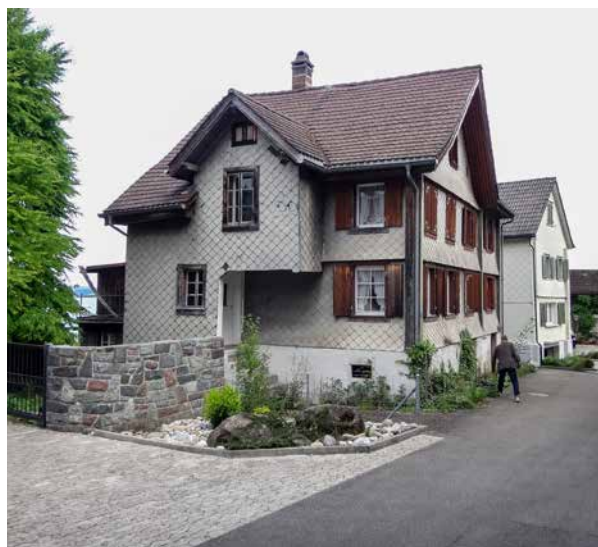
Il est prévu de démolir ce bâtiment et de le remplacer par une nouvelle construction. Photo: Philipp Maurer
