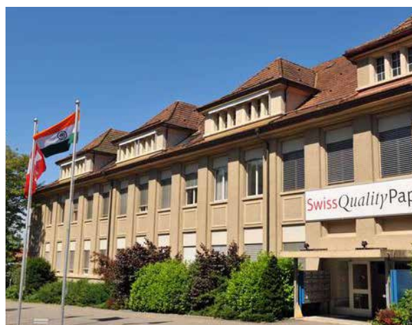
Le bâtiment administratif de la papeterie est mentionné dans l'ISOS en tant qu'élément individuel remarquable. Source: balsthal-collector.
