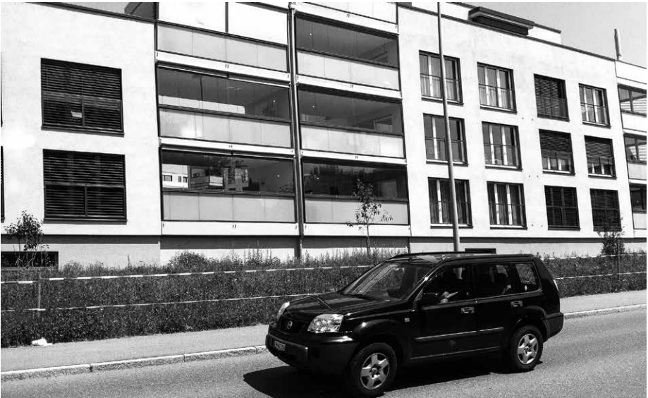
Architektonische Lösung mit Mehrwert: In Fehraldorf ZH wurden zwischen zwei Wohnhäuser verglaste Balkone eingebaut, die als «Lärmschutzwand» dienen – und erst noch einen zusätzlichen Aussenraum bieten.
